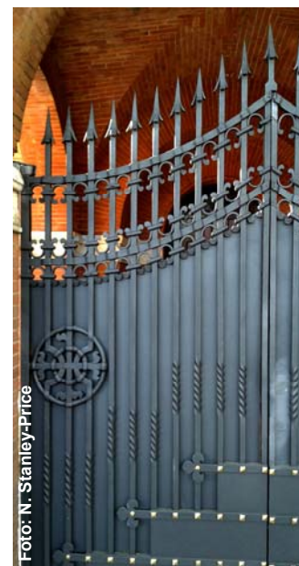
Il cancello di Via Caio Cestio restaurato (dettaglio)
