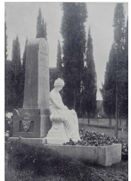
Il monumento subito dopo l'installazione
